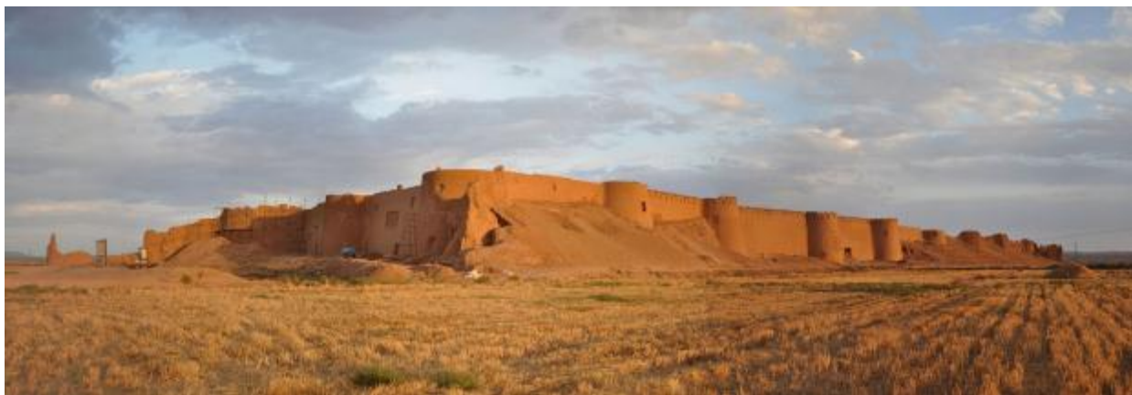
نمای غربی و شمالی شهر تاریخی بلقیس بعد از مرمت
