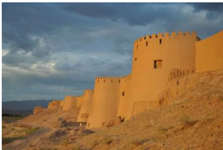
نمای غربی شهر تاریخی بلقیس بعد از مرمت
